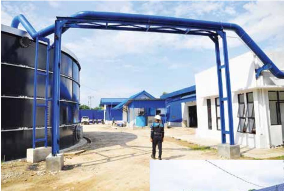
Proyek SPAM yang bekerja sama dengan Perumdam Kota Dumai dengan sistem BOT (*built-operate-transfer*) selama 20 tahun. Salah satu proyek mencakup pembangunan WTP 125 liter per detik (teknologi *nanofiltration membrane*).
