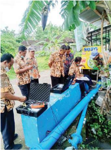
Deteksi kebocoran dengan metode clamp on menggunakan ultrasonic flow meter (UFM) di Unit Pengkok Perumdam Tirta Negoro.
