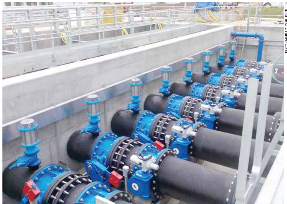
Pemasangan air valve pada discharge pompa.
