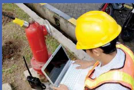
Deteksi bocor dengan noise logger.
